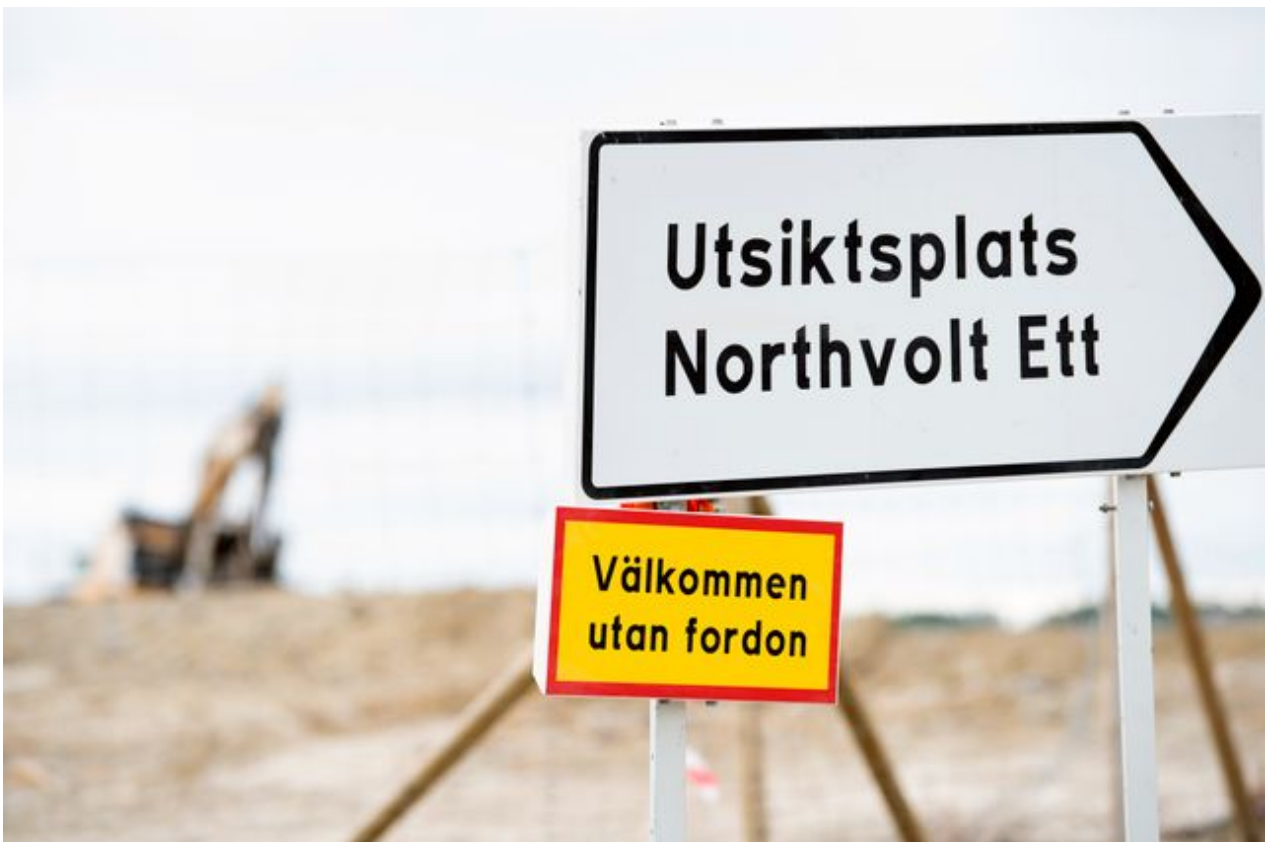
Strax öster om Skellefteå pågår bygget av Northvolt. Foto: Henrik Montgomery/TT
